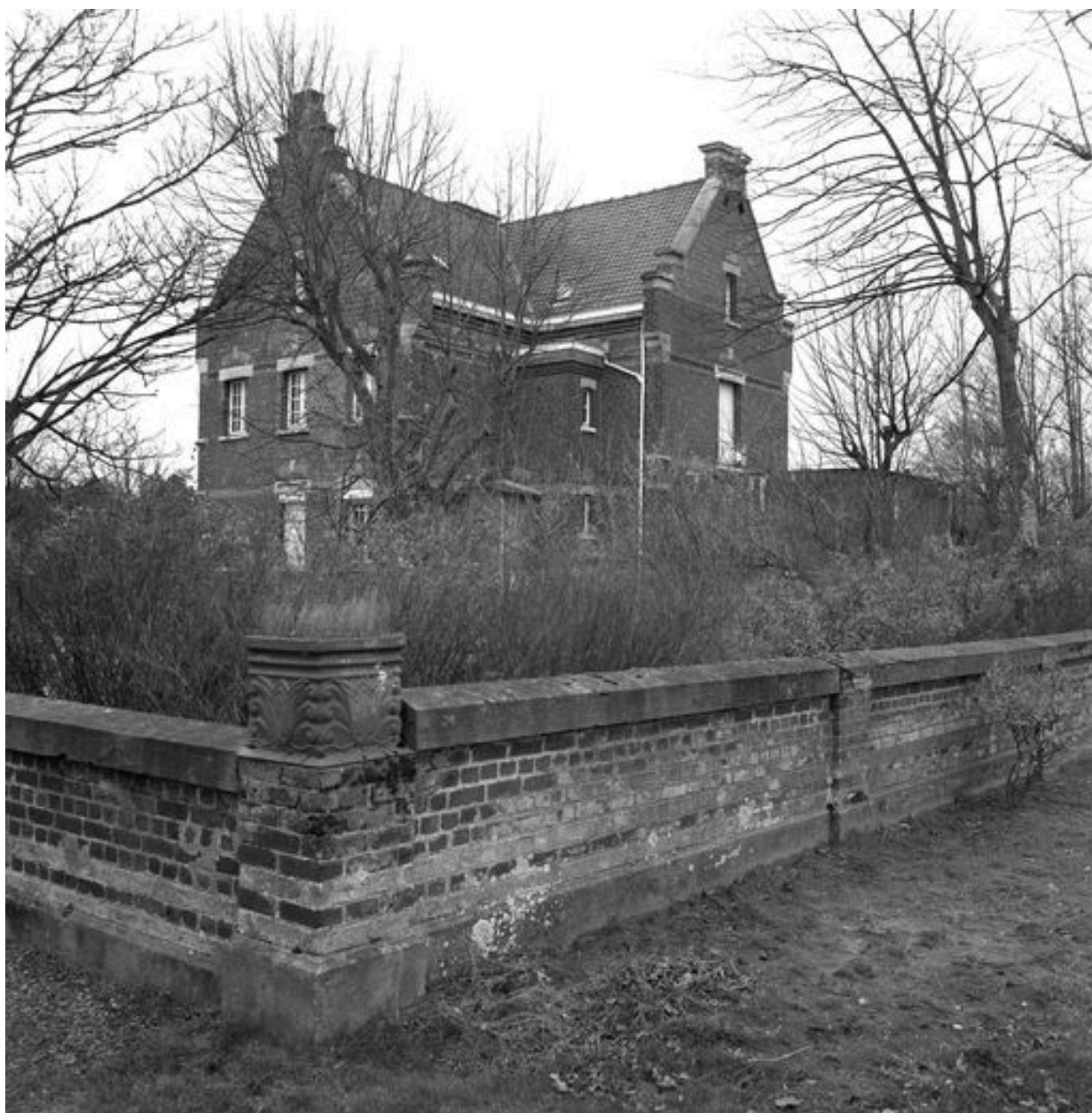
Habitation du directeur, élévation postérieure, vue générale prise de trois quarts gauche avec le mur de clôture du jardin au premier plan.
