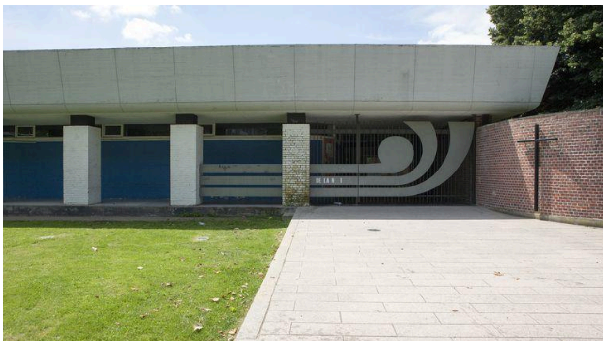
Élévation nord, entrée de l'église.
