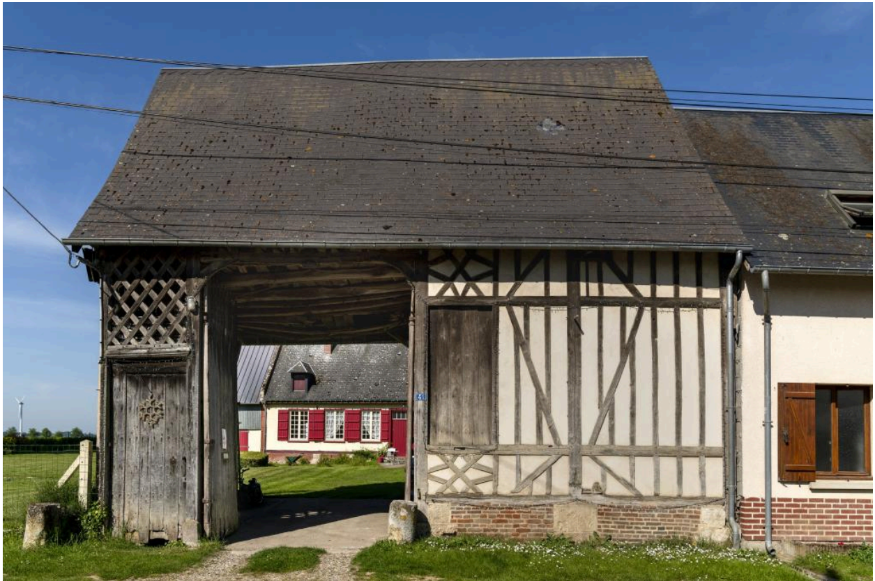
Ancien presbytère avec sa grange sur la rue et son logis en fond de cour, n°41 rue Principale, vue depuis la rue.
