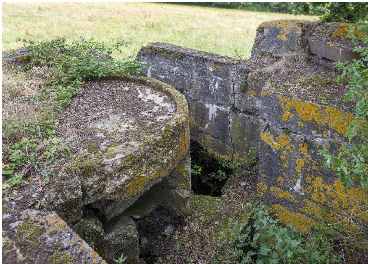
Plateforme nord-est et observatoire casematé
