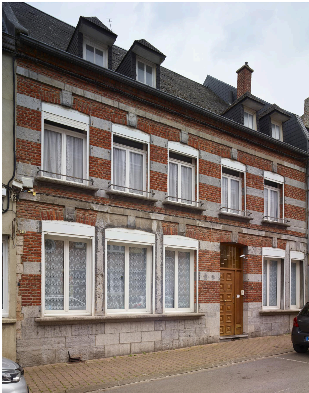
Maison de maître avec date portée (1807) - 14, rue Tanis. Vue orientée nord - sud.
