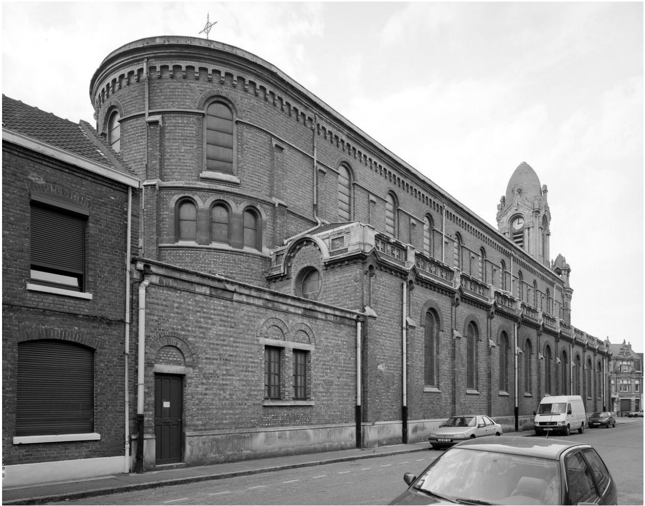
Vue générale du sud-est.
