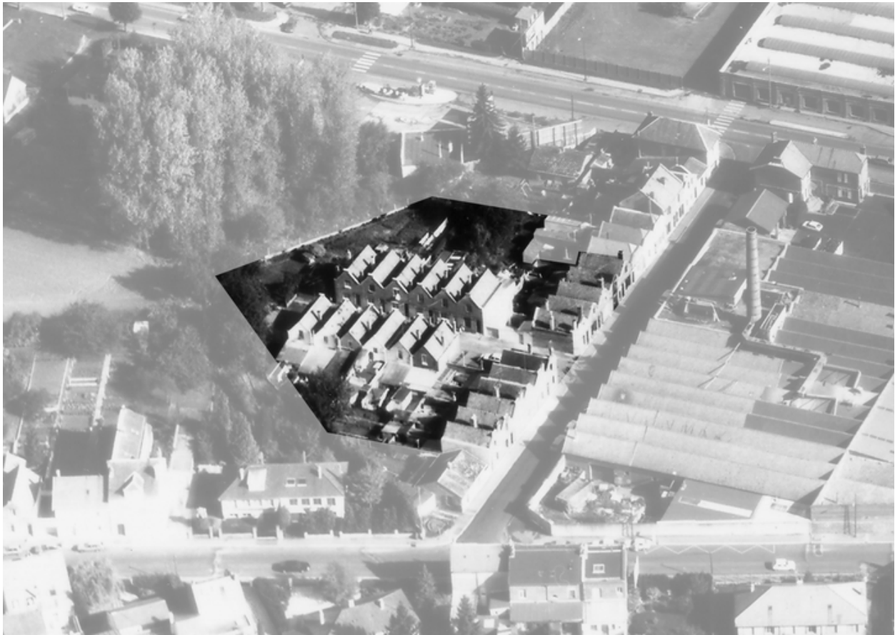
Vue aérienne de la cité en 1989.
