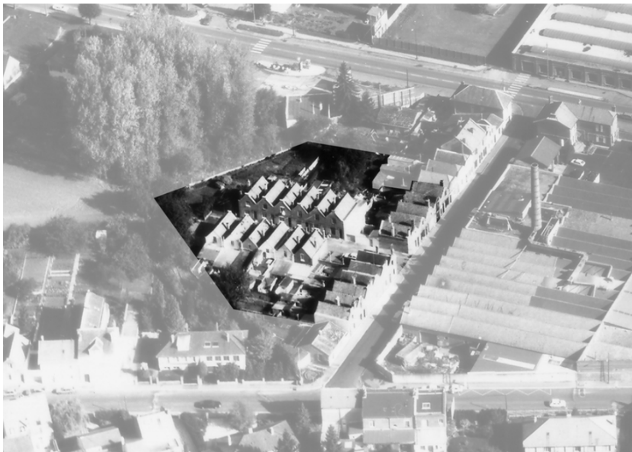
Vue aérienne de la cité en 1989.
