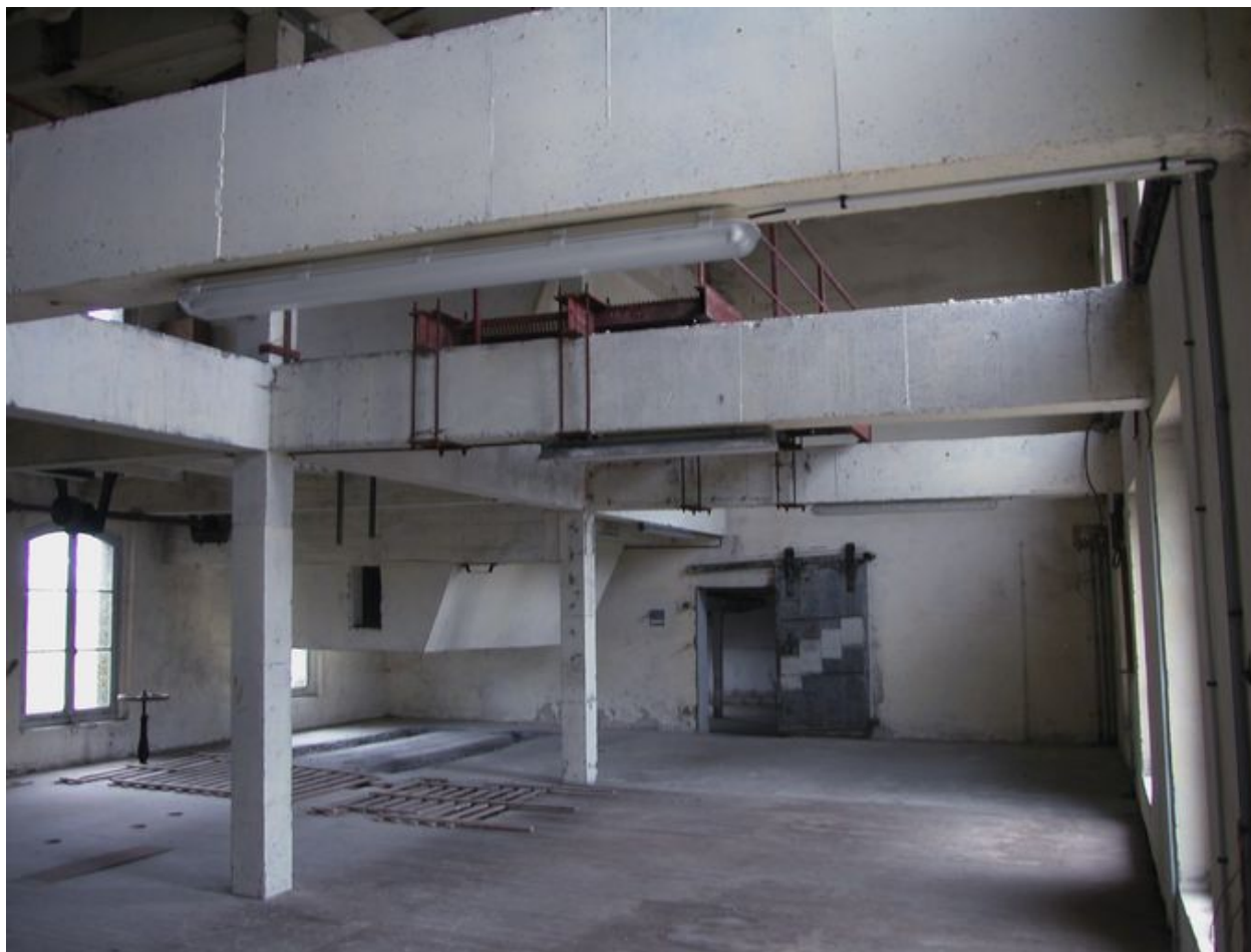
Intérieur du premier étage de la minoterie.
