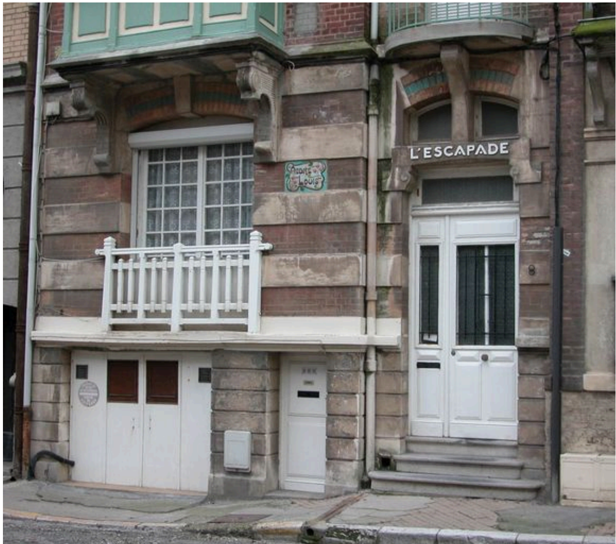
Détail du sous-sol semi-enterré habitable.
