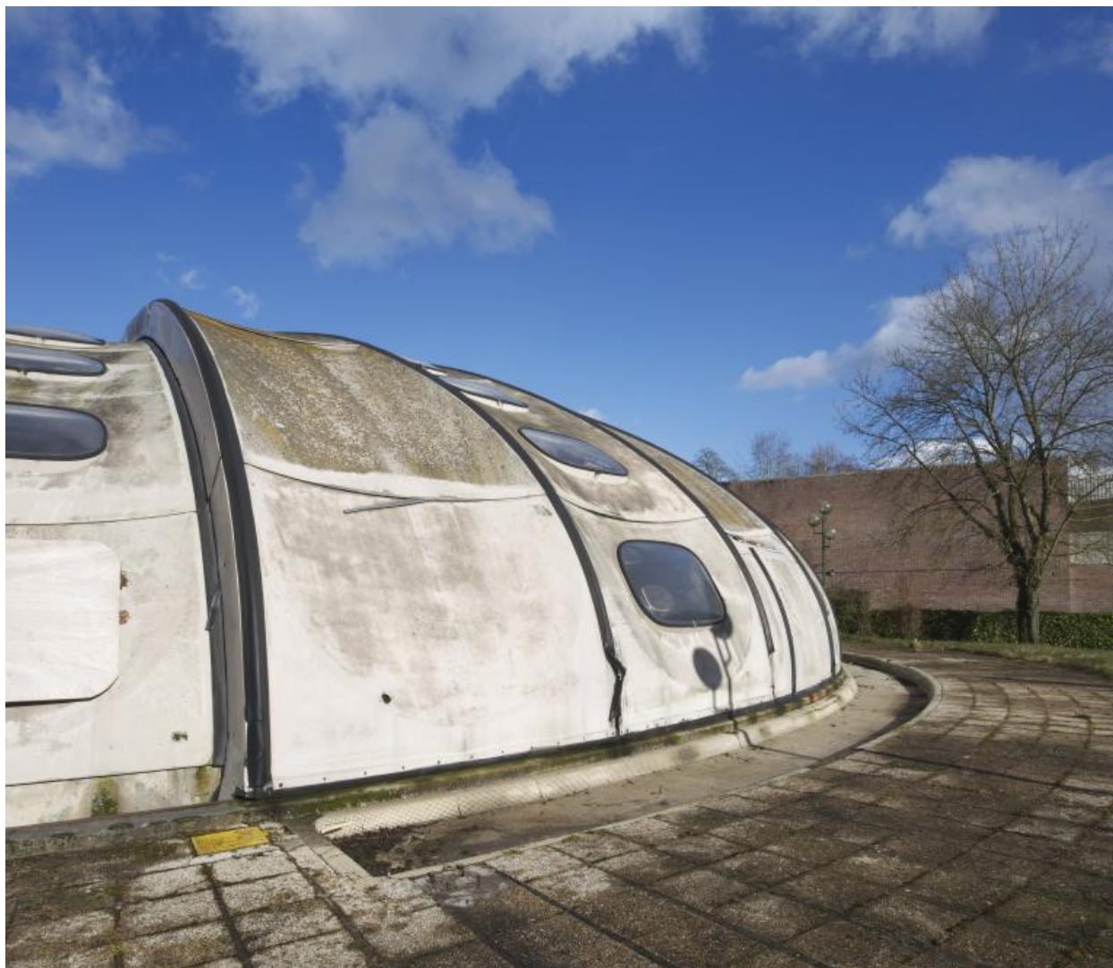
Vue de détail sur la jonction entre la partie mobile et la partie fixe.
