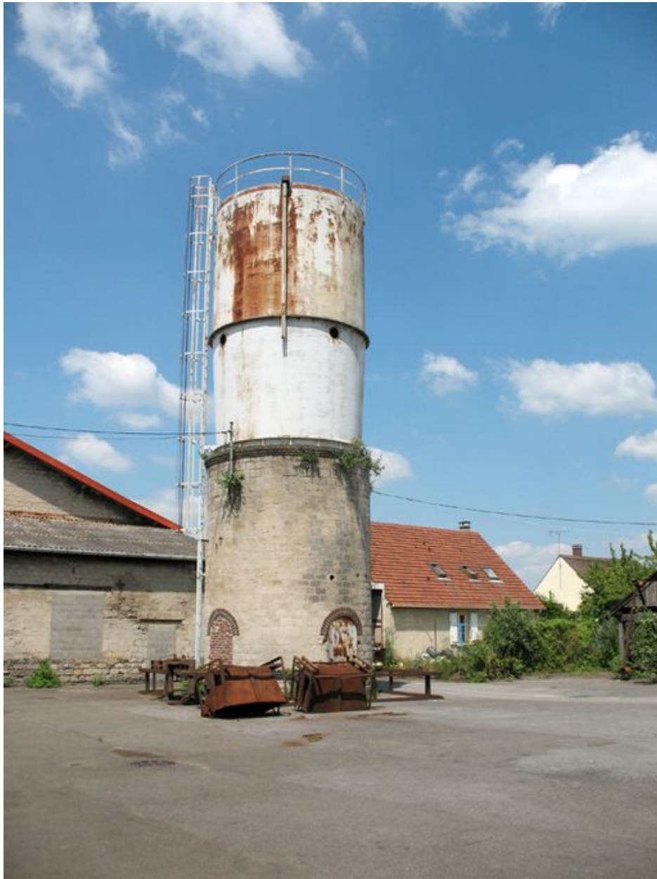
Réservoir d'eau de l'usine dans la cour de la tréfilerie.
