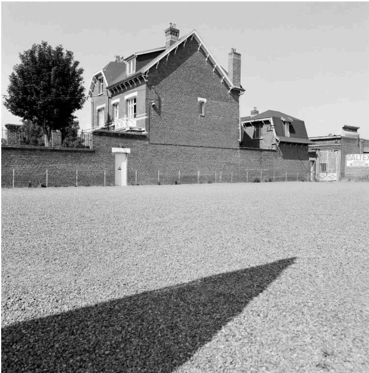
Logement patronal. Vue prise depuis la rue, vers l'ouest.
