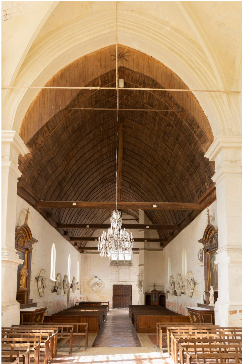
Vue intérieure vers la nef.
