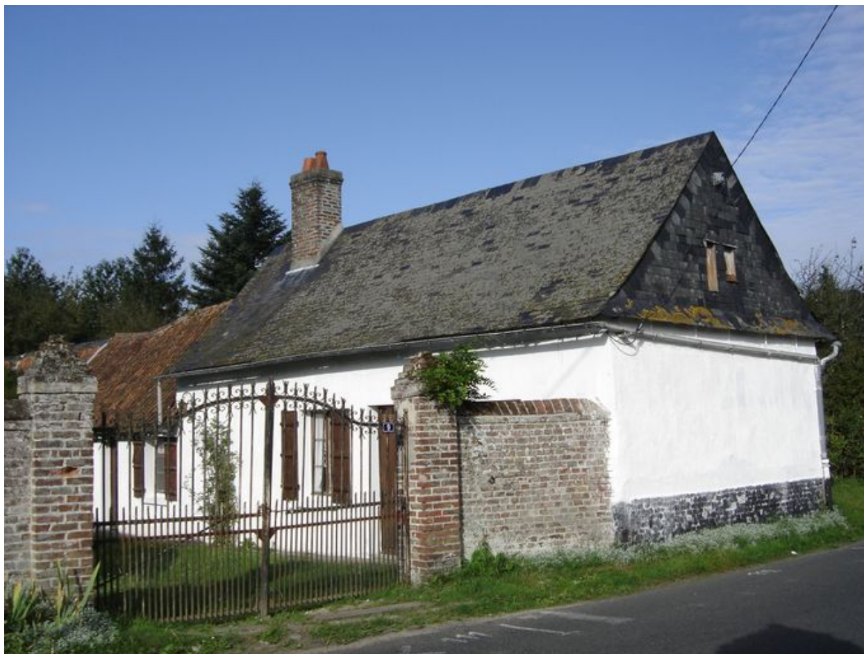
Vue du logis sur rue.
