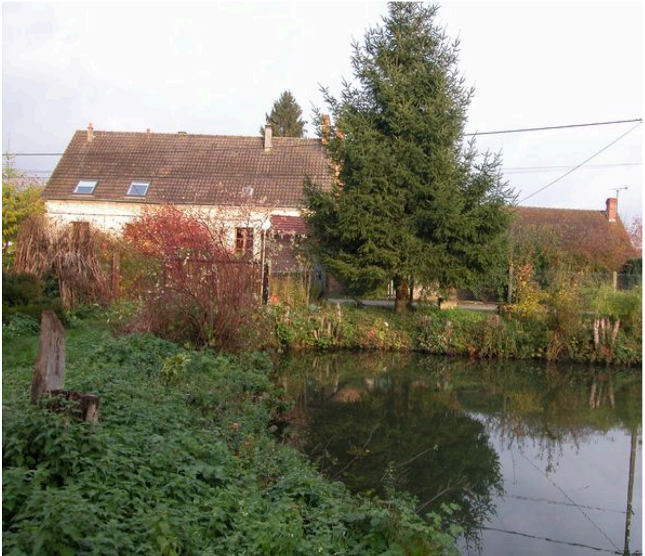
Vue d'ensemble avec le bassin de rétention au premier plan.
