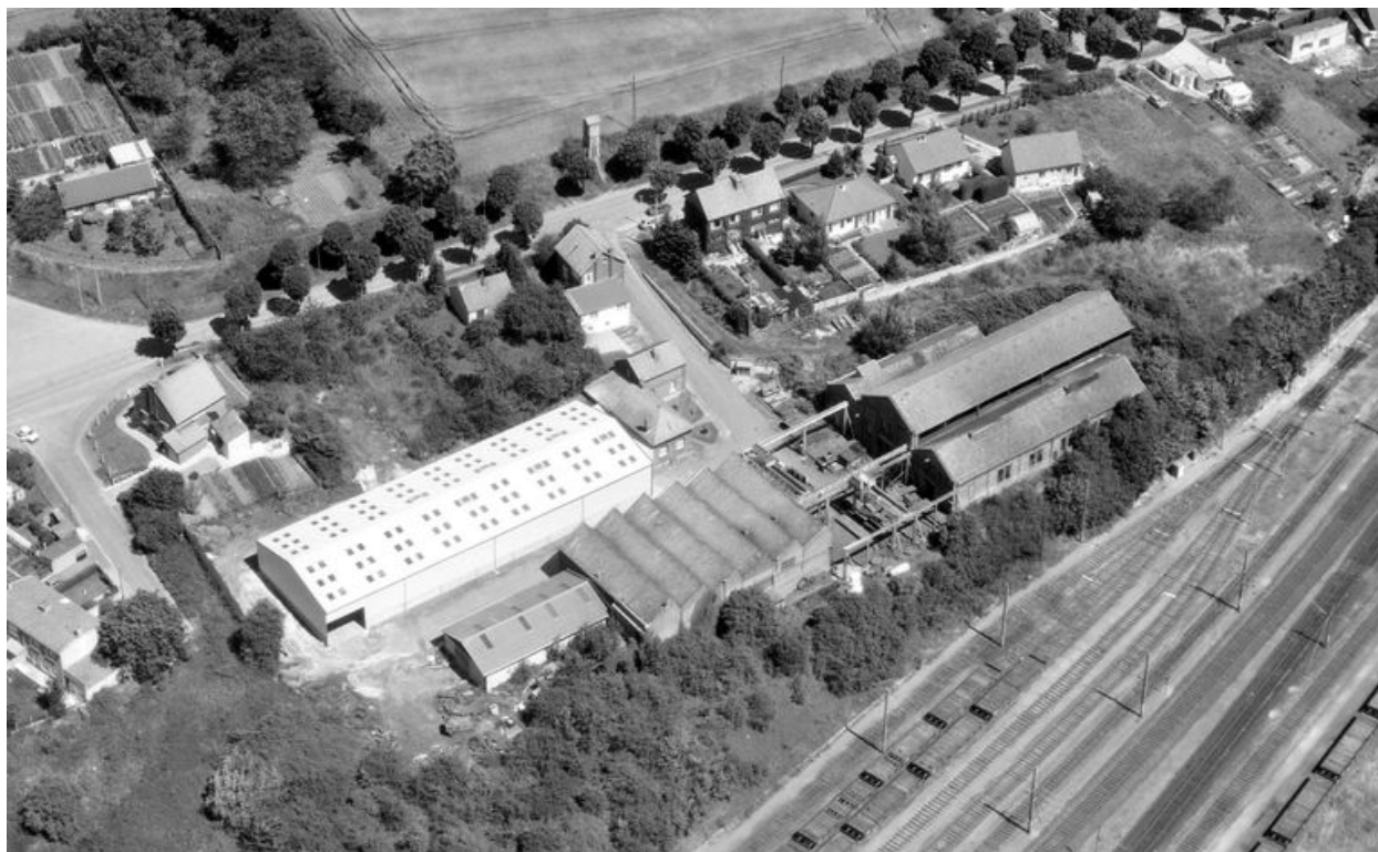
Vue aérienne, flanc sud-ouest.
