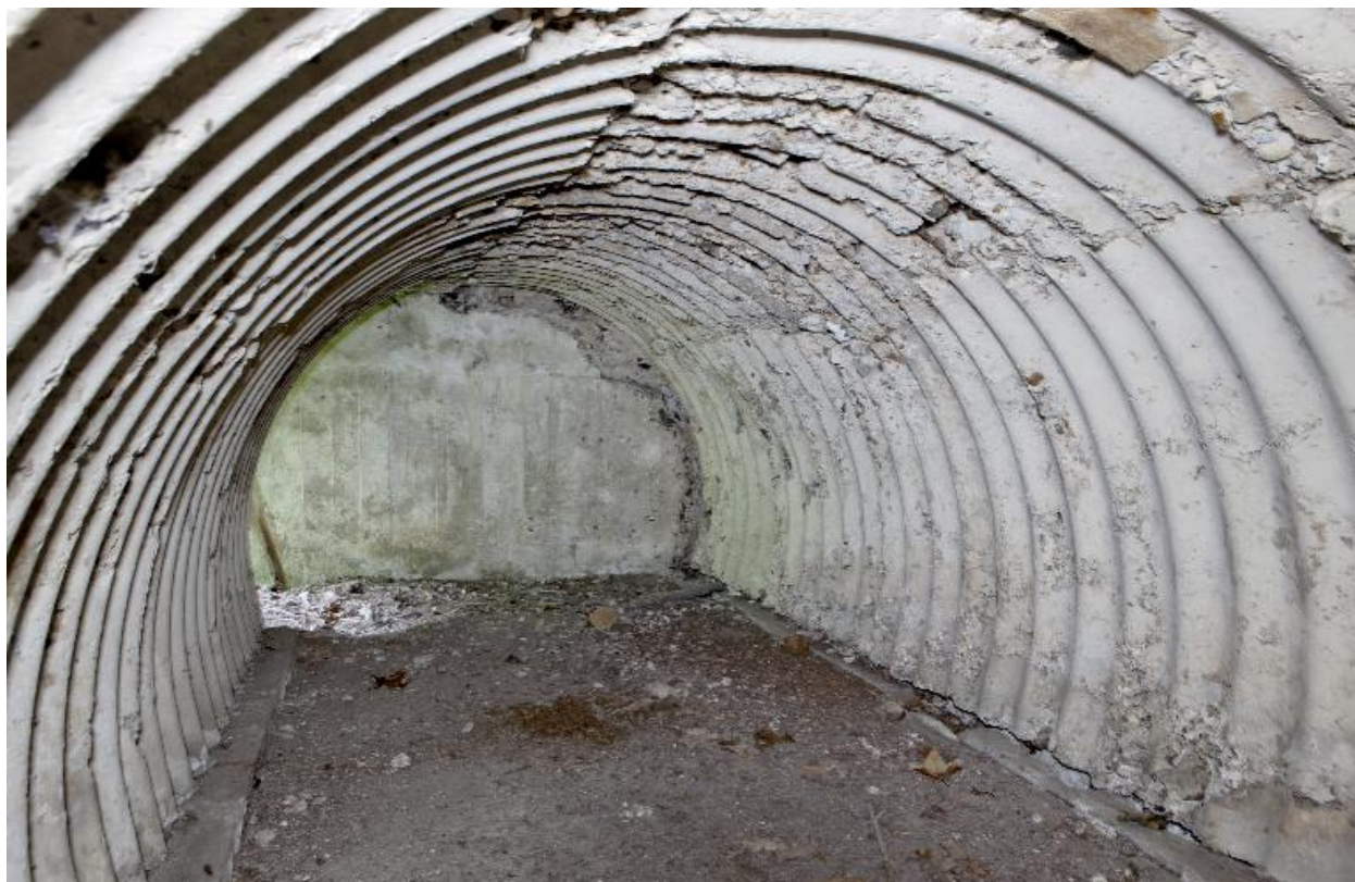
Casemate c) : Vue intérieure
