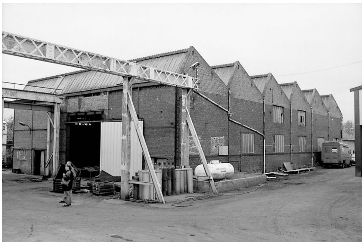
Atelier de fabrication 2, flanc nord-ouest.
