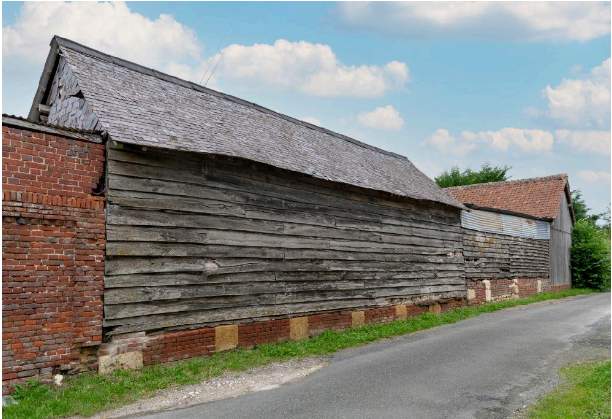
Bâtiment agricole essenté en blins de bois, n°45 rue Principale, vue depuis le sud-ouest.
