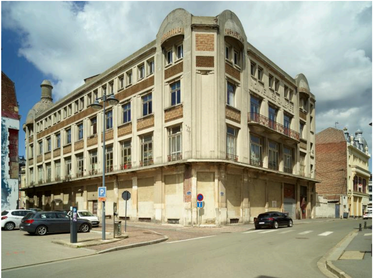
Vue d'ensemble extérieure des façades sud et ouest donnant sur les rues Anatole-France et Saint-Jacques.
