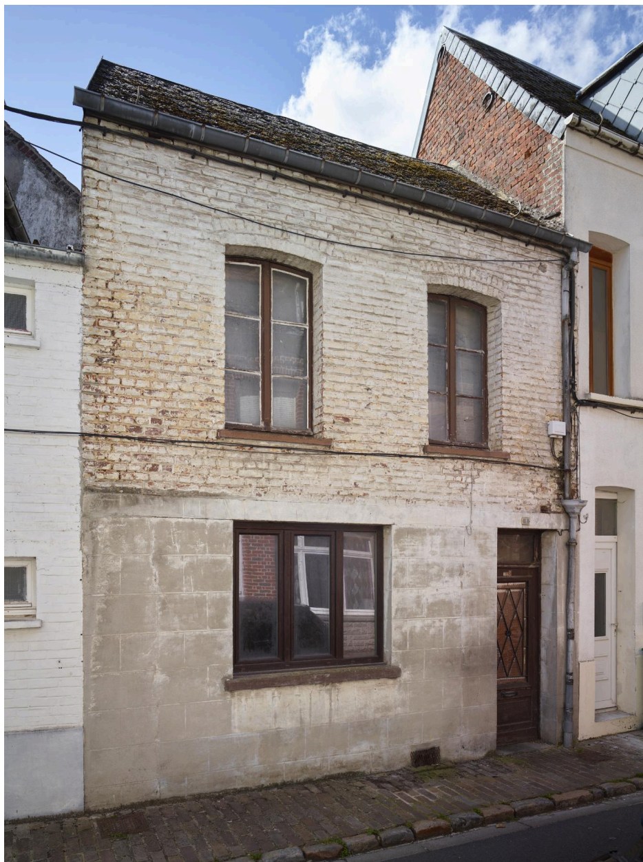
Maison de journalier - 1, rue de Valory. Le rez-de-chaussée a été modifié.
