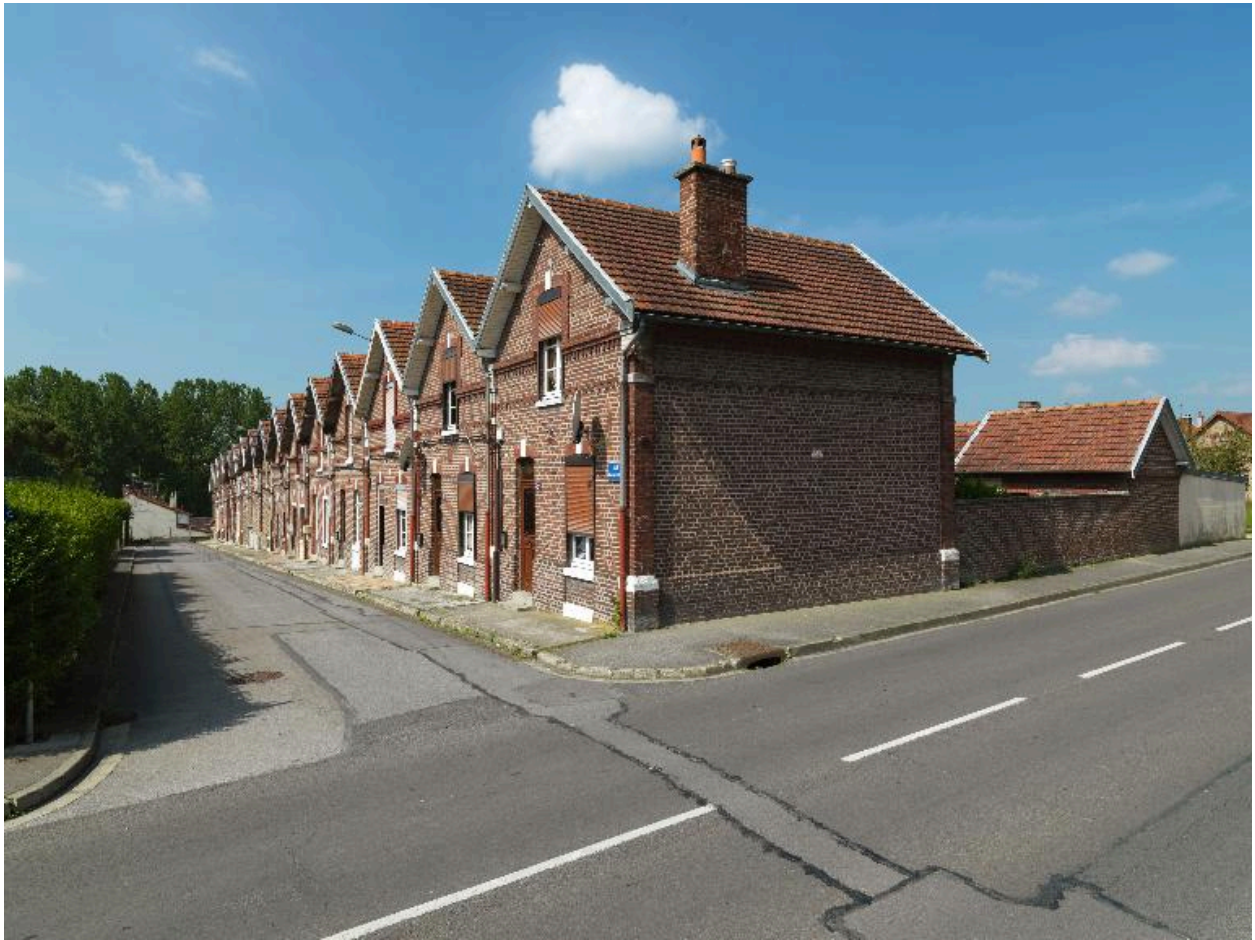
Vue d'ensemble de la cité Hugo
