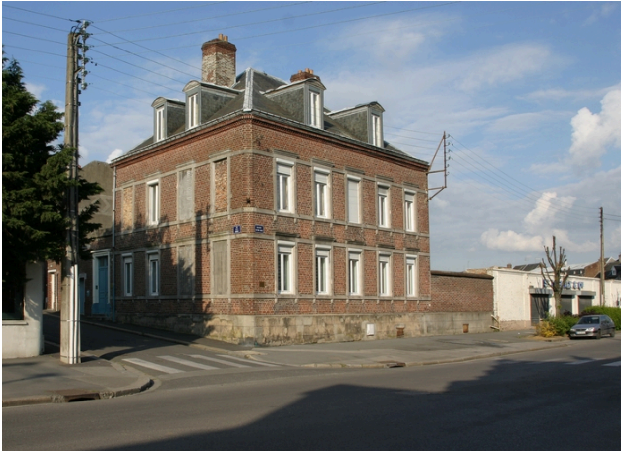
Ancien logement patronal de la minoterie façade postérieure, boulevard Victor Hugo.
