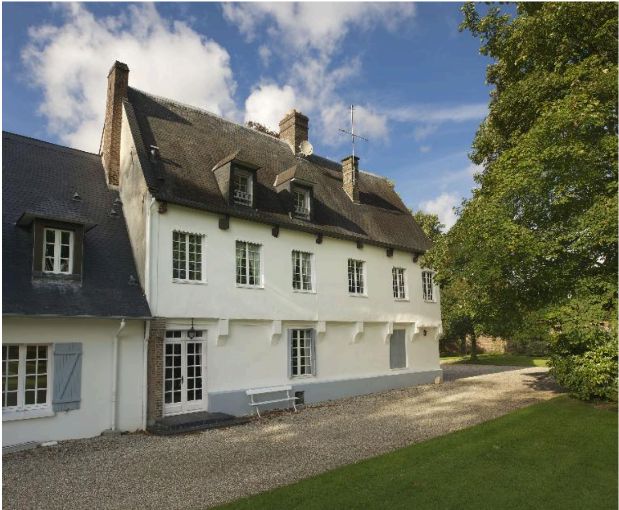
Façade antérieure du logis du 16e siècle.
