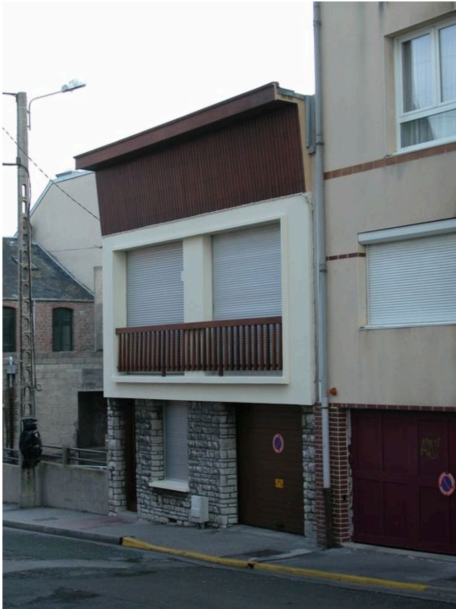
Maison, rue Maurice-Dupont (1982 AE 686).
