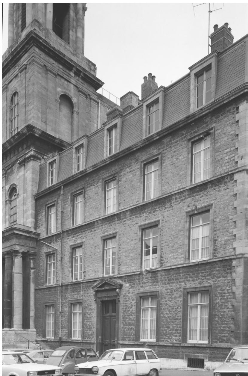
Presbytère. Façade sur parvis.
