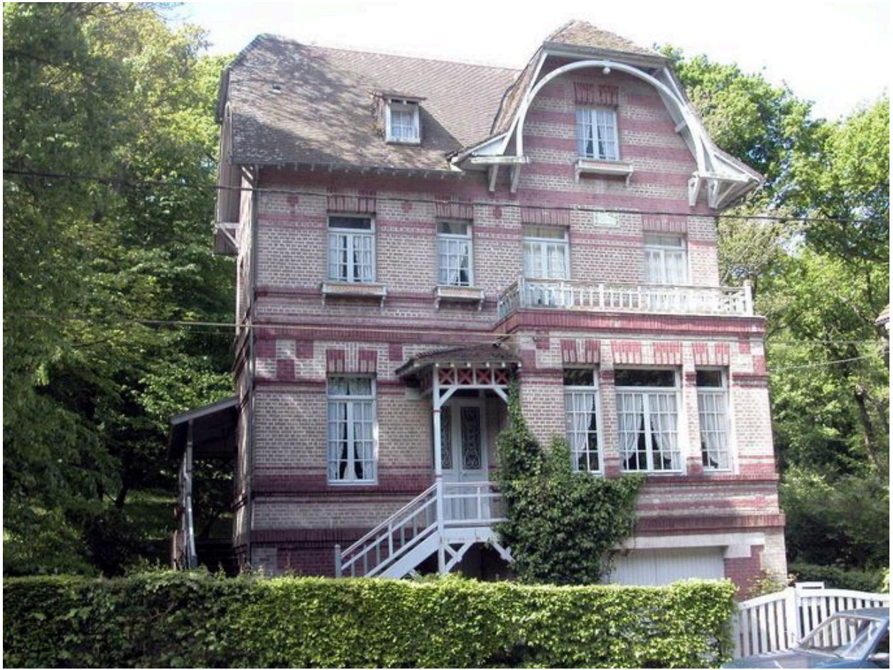
Vue d'ensemble depuis l'avenue.
