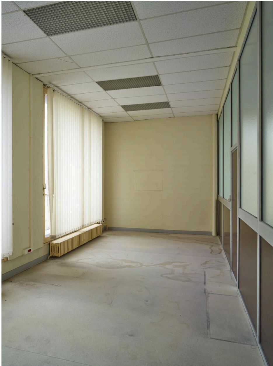
Rez-de-chaussée, bureau côté nord de la CPAM.
