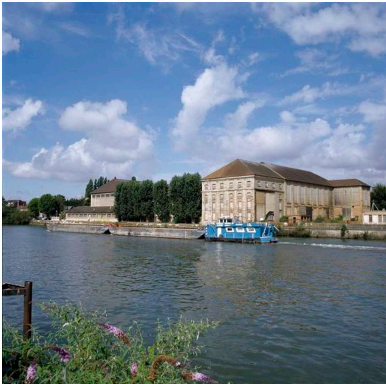
Les bâtiments de l'ancienne sucrerie.
