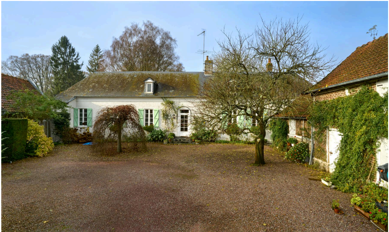
Maison et cour, depuis l'est.
