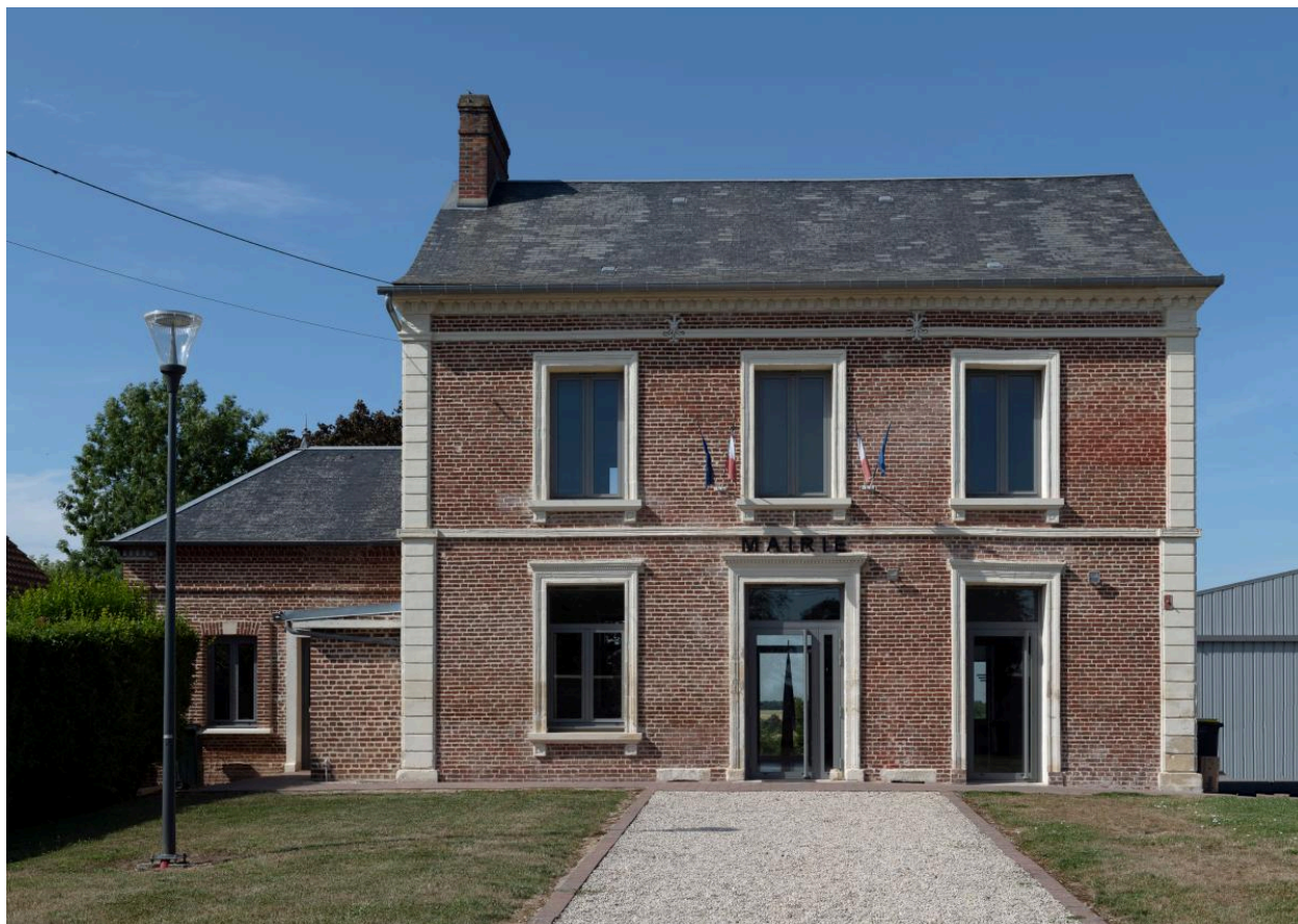
Mairie (ancien presbytère), vue depuis le nord-ouest.
