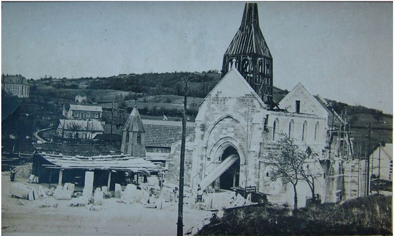
Vue de l'église en reconstruction, près de l'église provisoire, le château en arrière-plan (AP).
