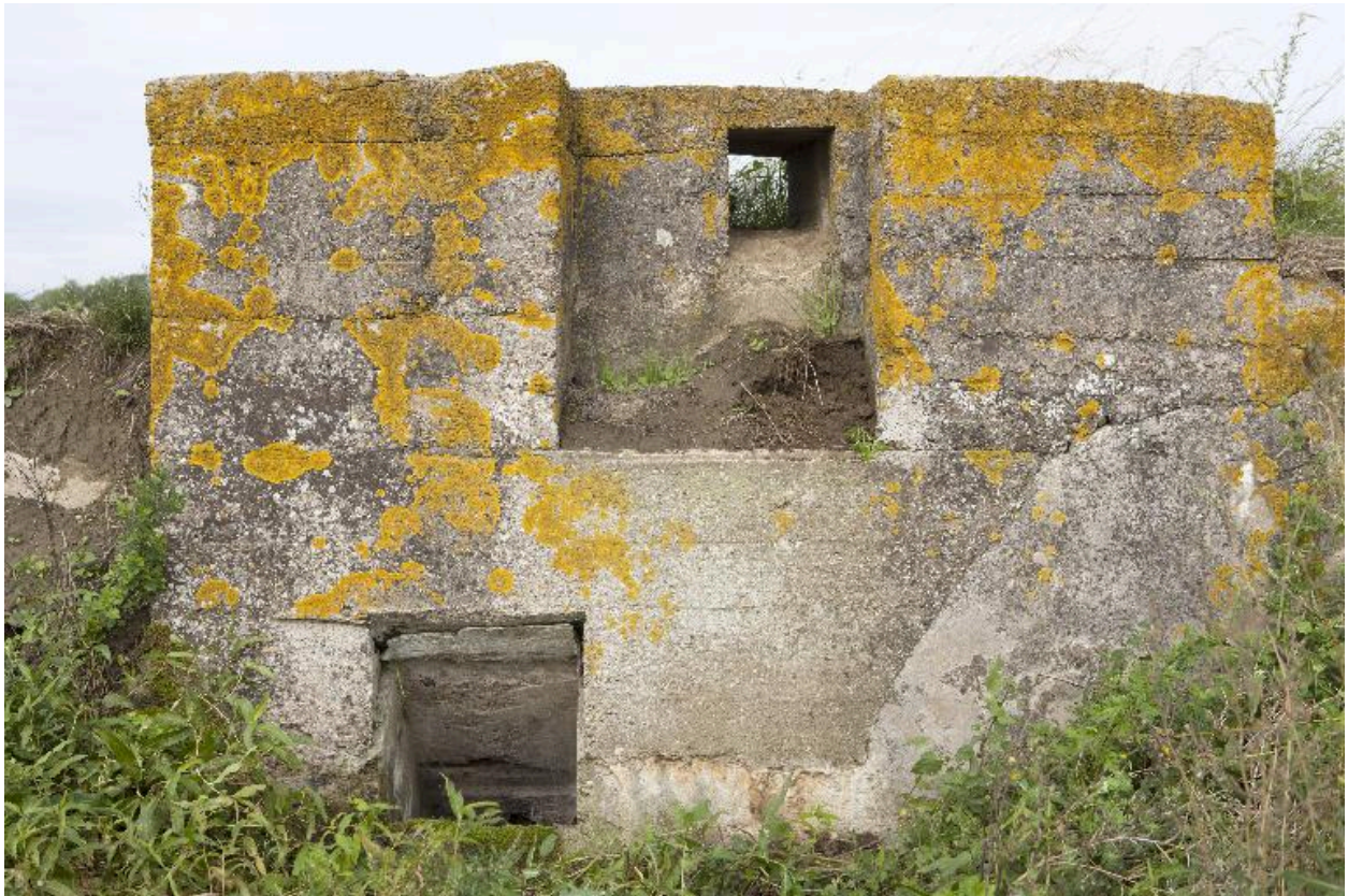
Poste de tir avec, à gauche, la resserre à mitrailleuse
