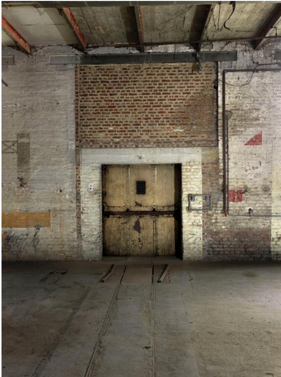
Monte-charge de l'atelier de tissage du niveau inférieur.
