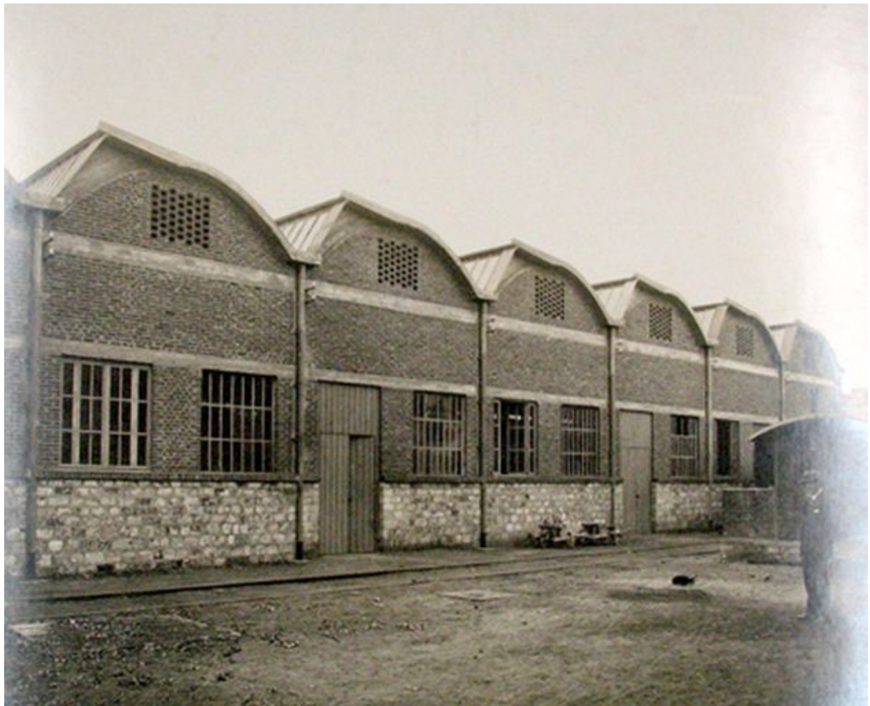
Agrandissement des ateliers par les architectes Perret : élévation en brique et couverture en béton en sheds, début décennie 1920 (IFA ; 535 AP 651/7).
