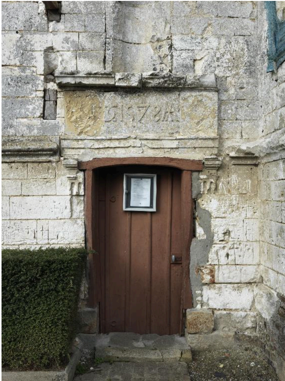
Détail du fronton de la porte d'entrée.
