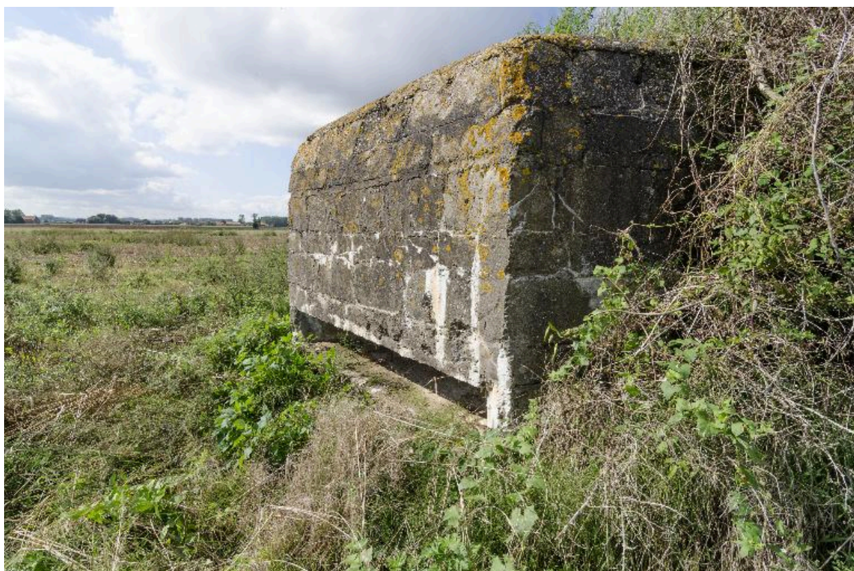
Vue vers le nord-ouest. Embrasure de tir de la tourelle sud
