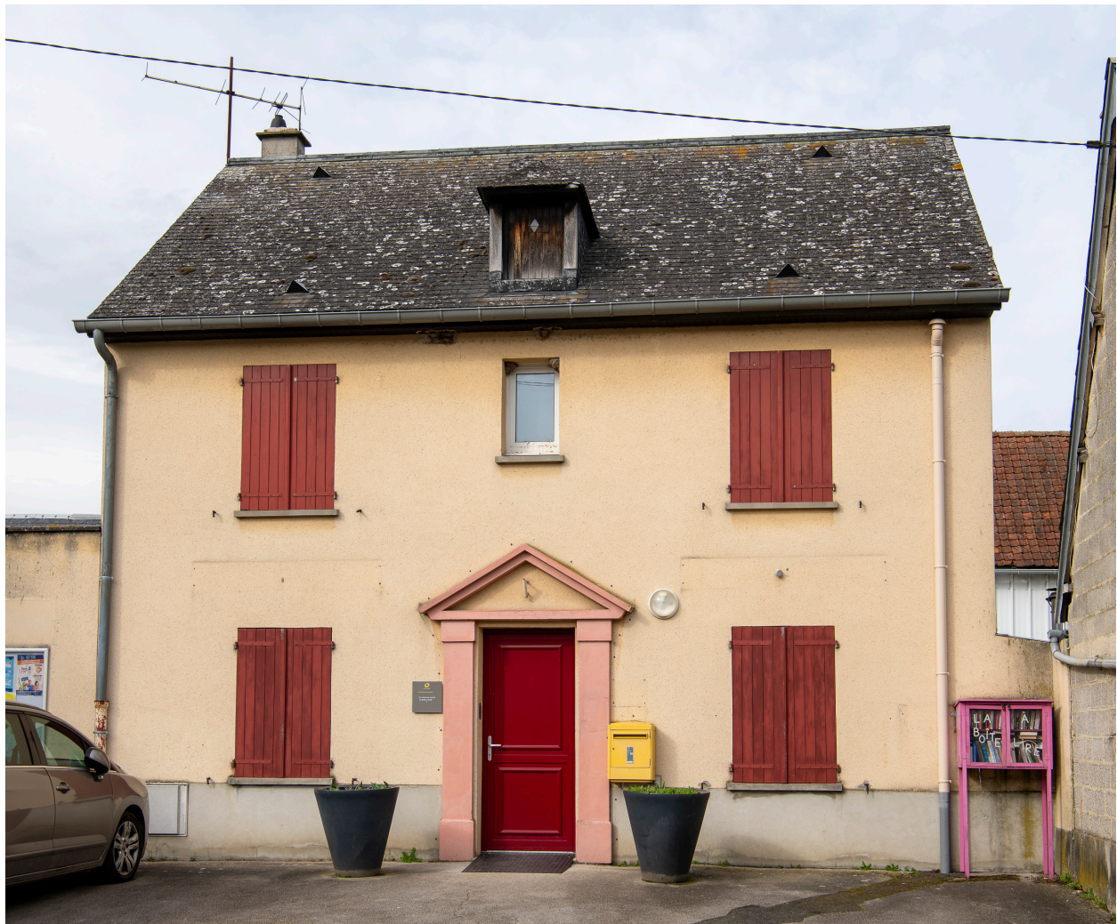
Agence postale, n°5 bis de la rue de la Ville, vue depuis le sud.
