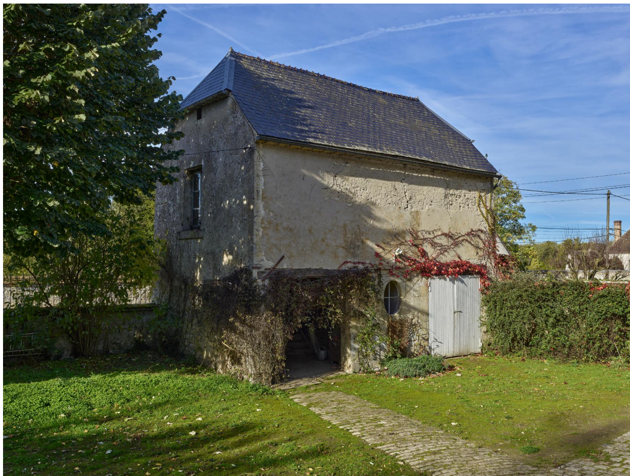
Vue du sud-est de la remise.
