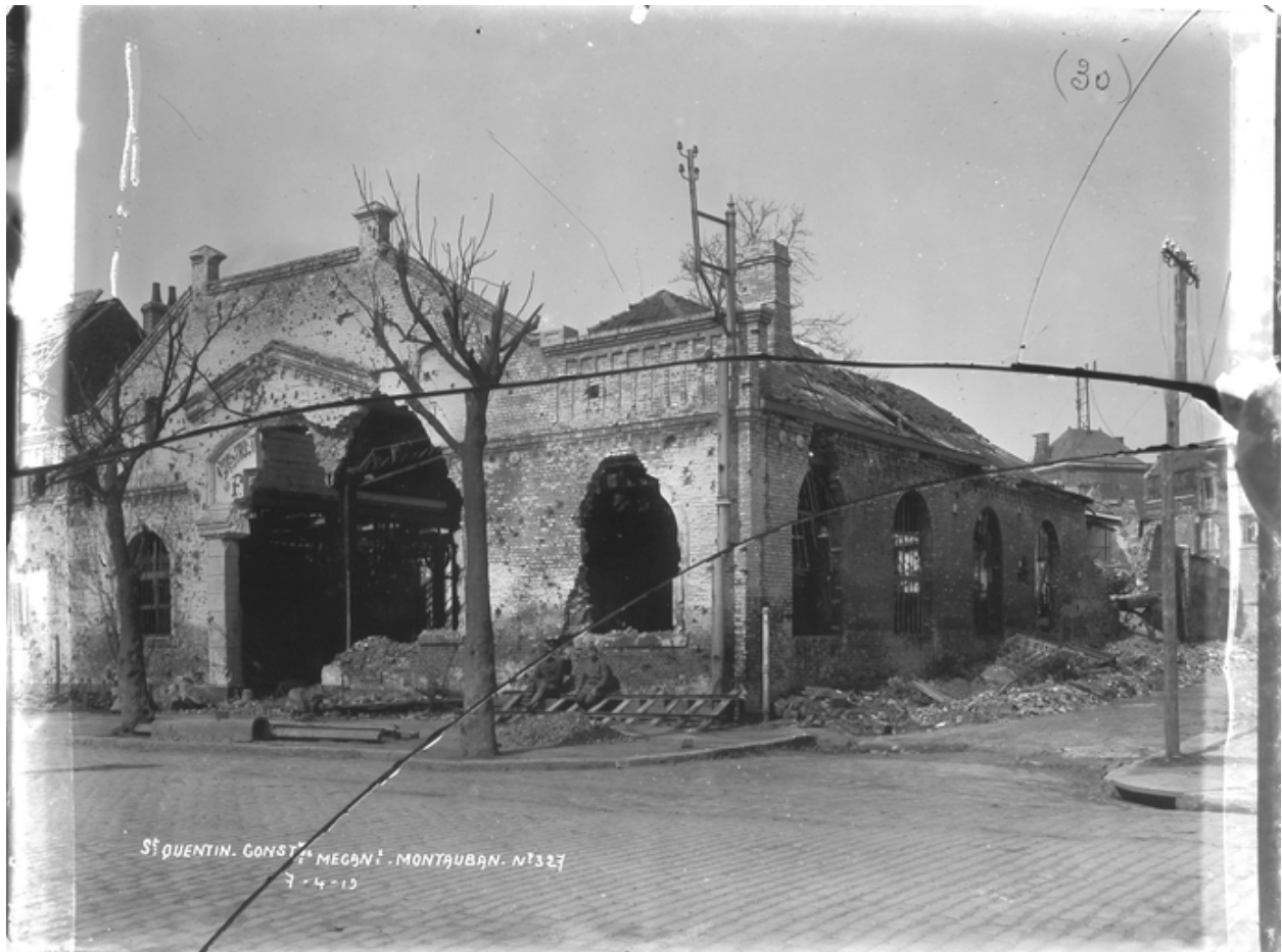
Les ateliers Moret, à l'angle du boulevard Victor-Hugo et de la rue des Fossés Saint-Martin, 1919 [la légende indique par erreur les ateliers Montauban] (AD Aisne).
