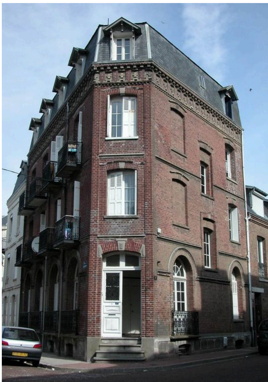
Vue d'ensemble depuis la rue Jules-Barni.
