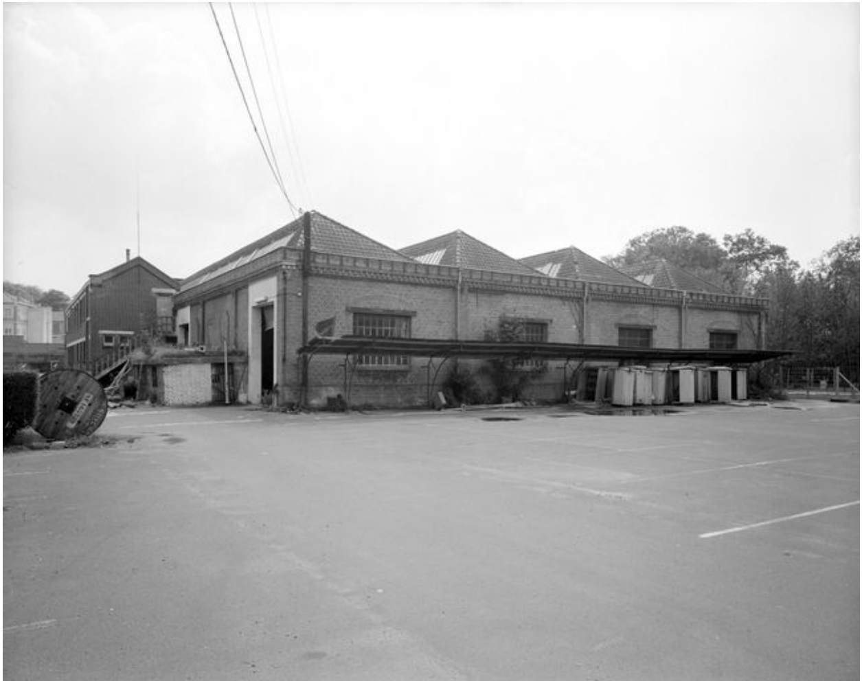
Atelier de fabrication, flanc nord-ouest.
