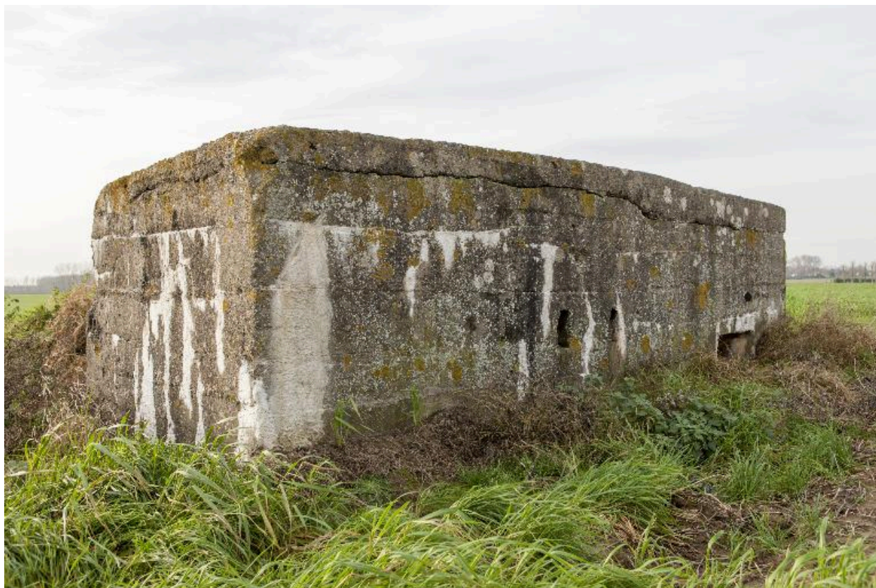
Vue de trois-quarts arrière, vers l'ouest
