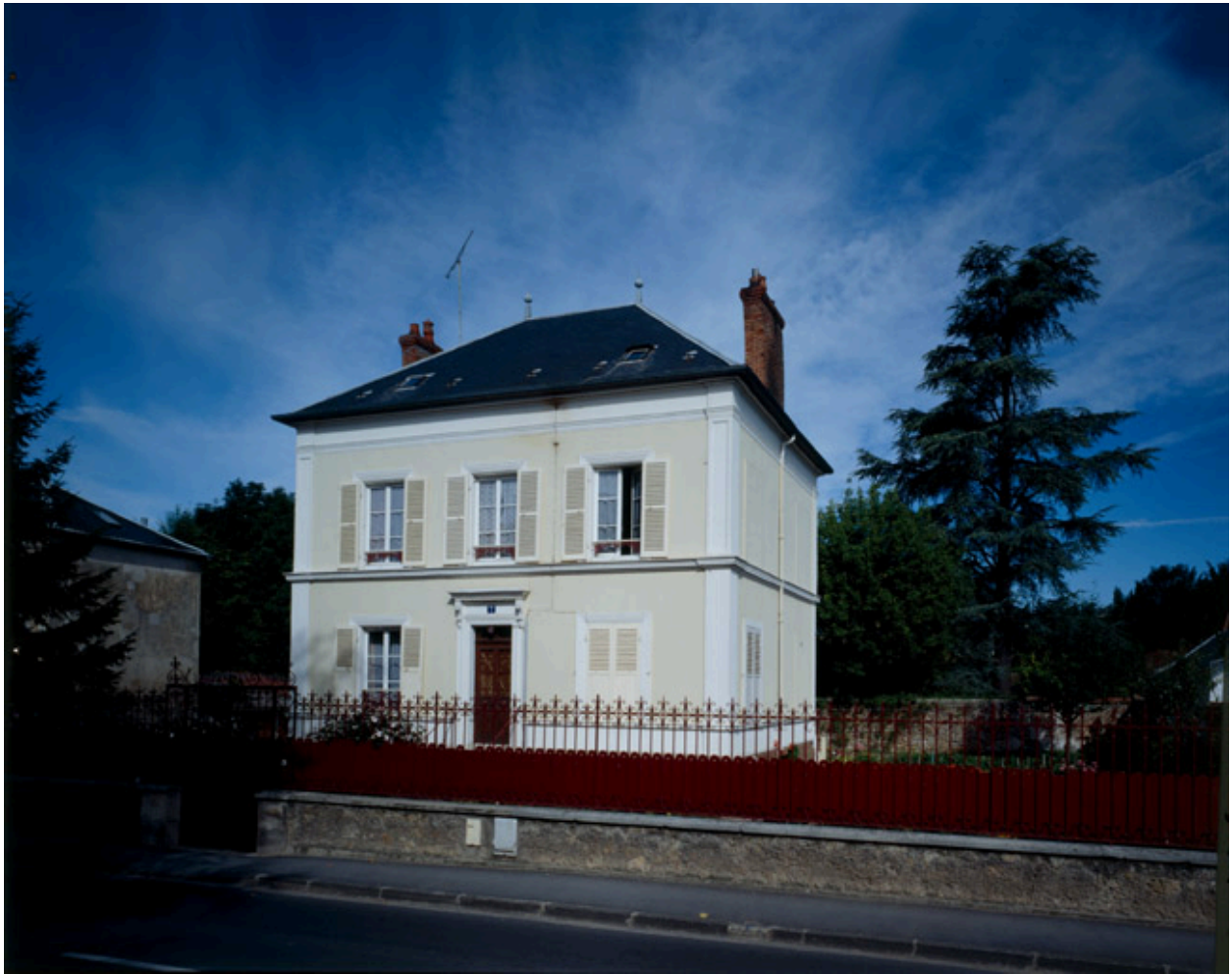
Vue d'ensemble depuis la rue.
