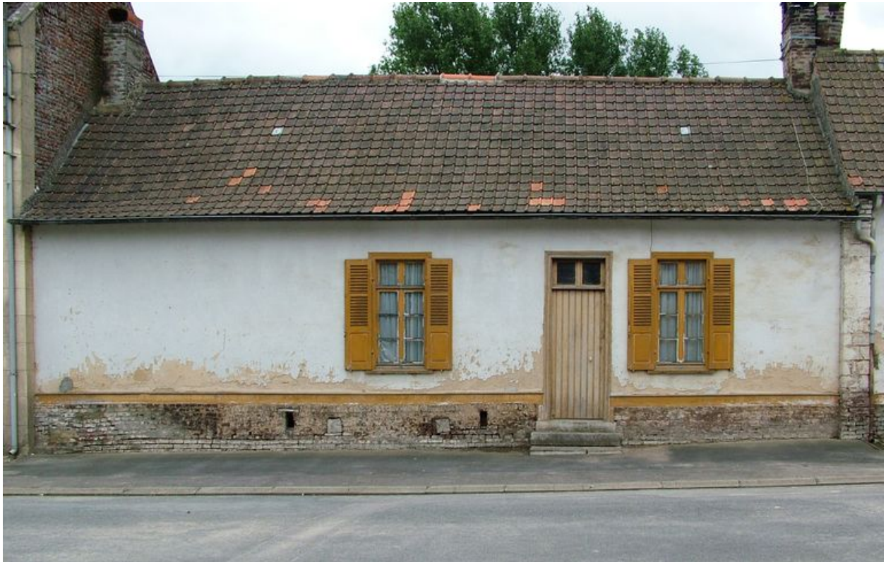
Façade du logis sur rue.
