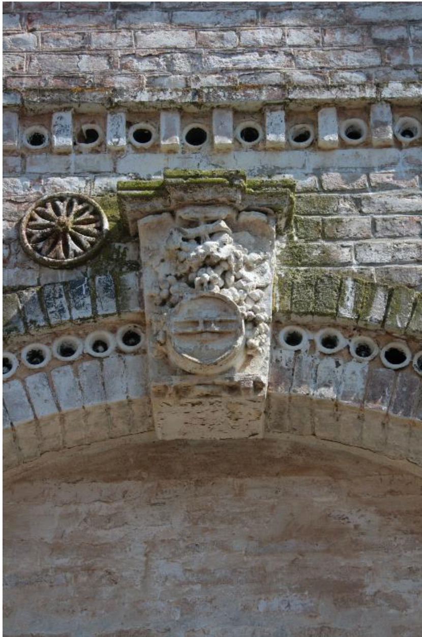
Détail de la clé de voûte de l'entrepôt du marchand de vins.
