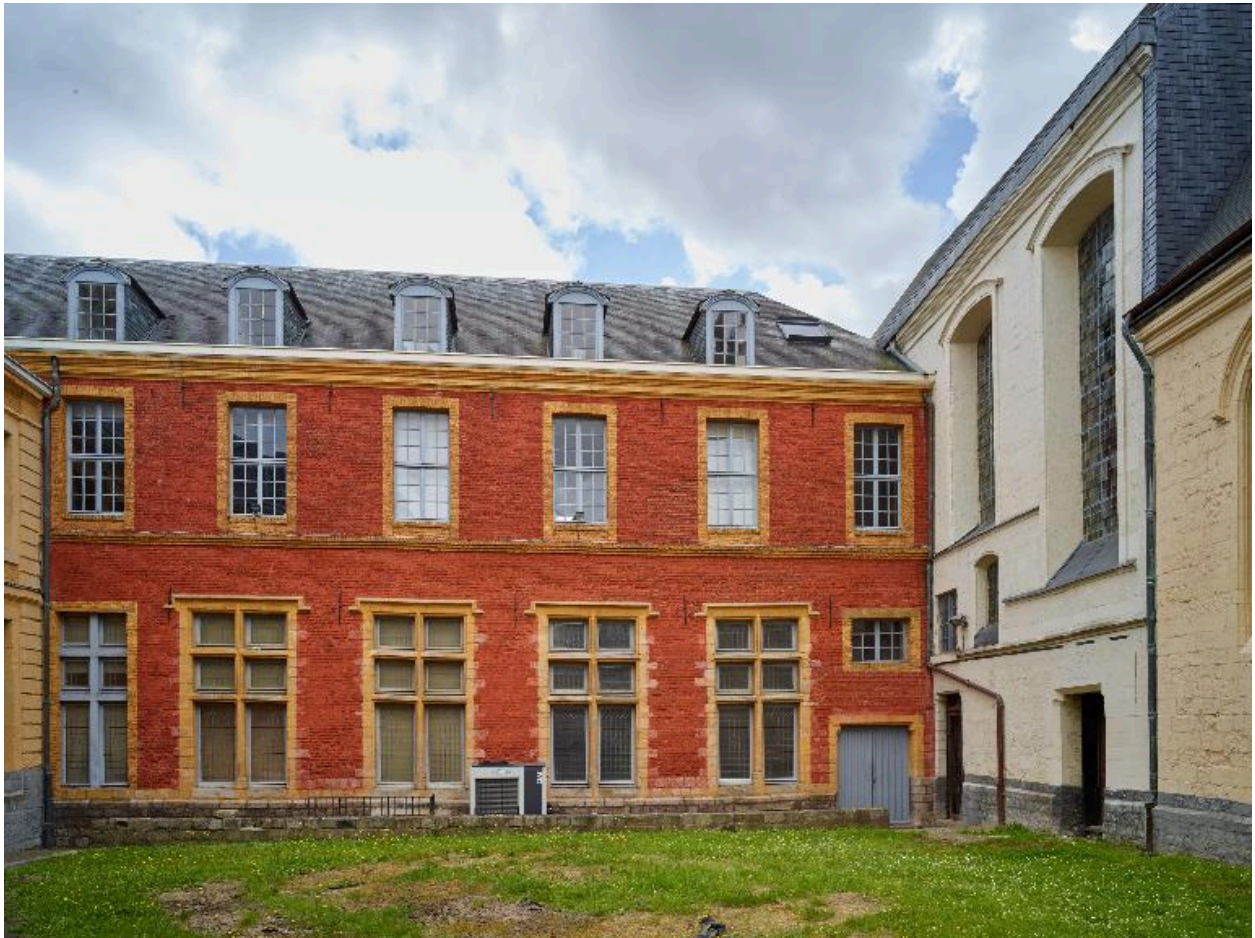
Cour secondaire, élévation du bâtiment situé à l'est de la cour, abritant l'ancienne salle Desmet.
