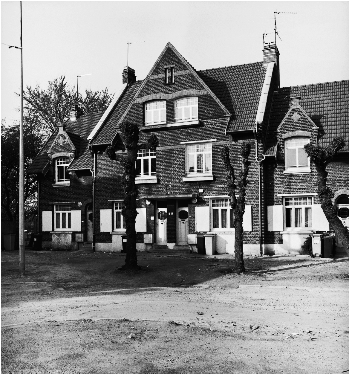
Vue partielle du troisième groupe de maisons, aile est.
