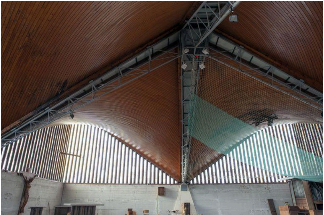
Vue de la voûte.
