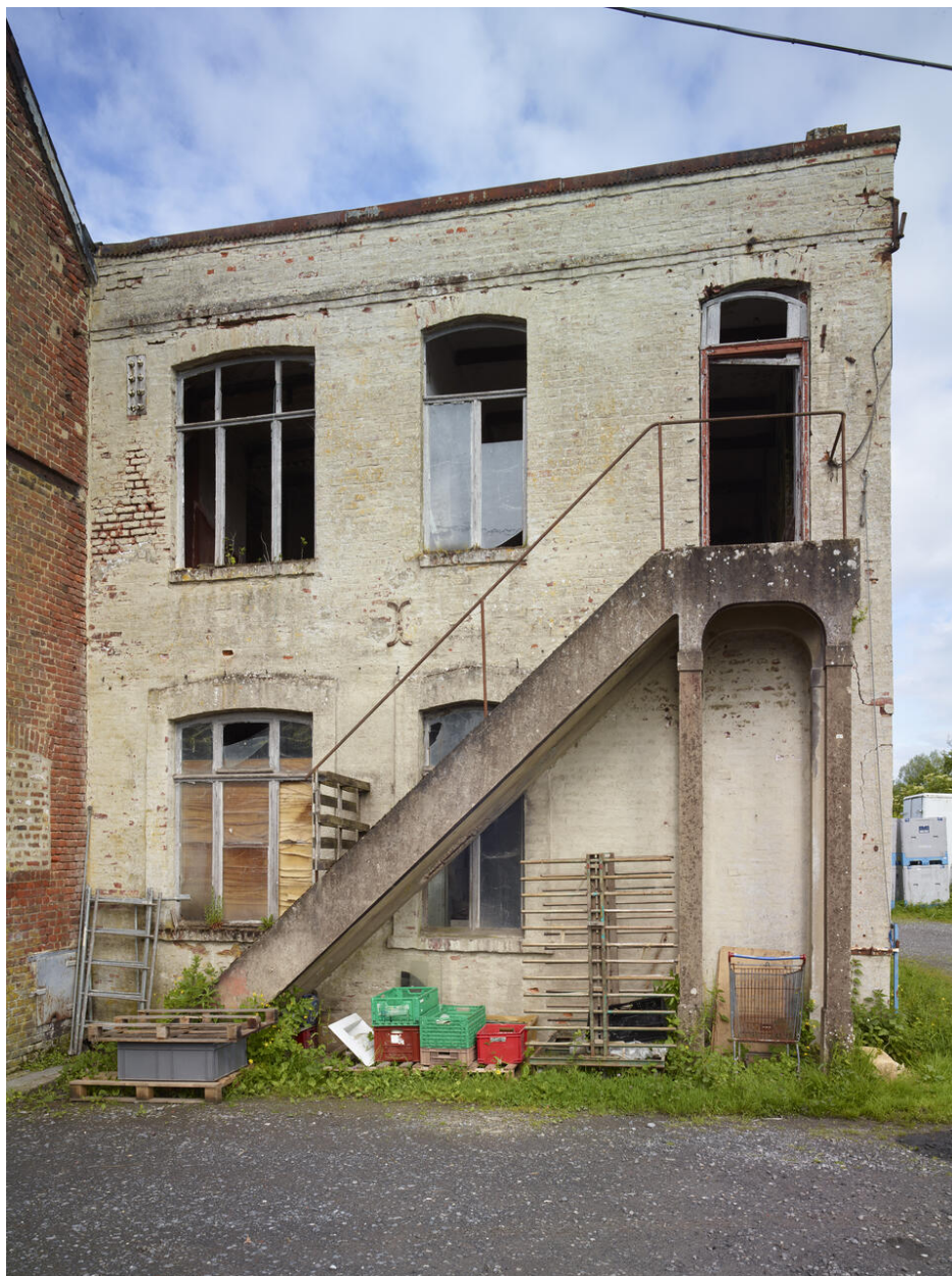
Bâtiment des générateurs, élévation sud.
